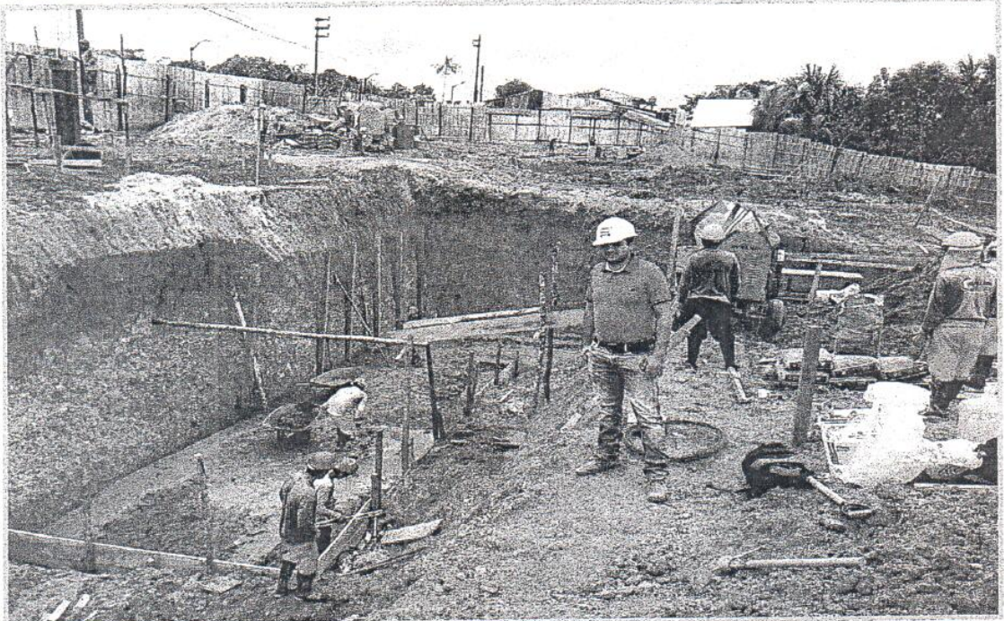
FOTO N°08: Vaceo de Mortero en Zapatas.
