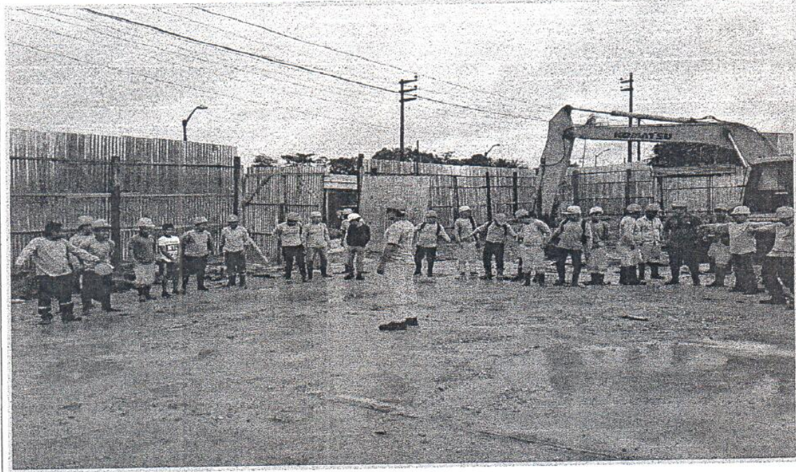
FOTO N°01: Se Observa Charlas de Seguridad en Obra.
