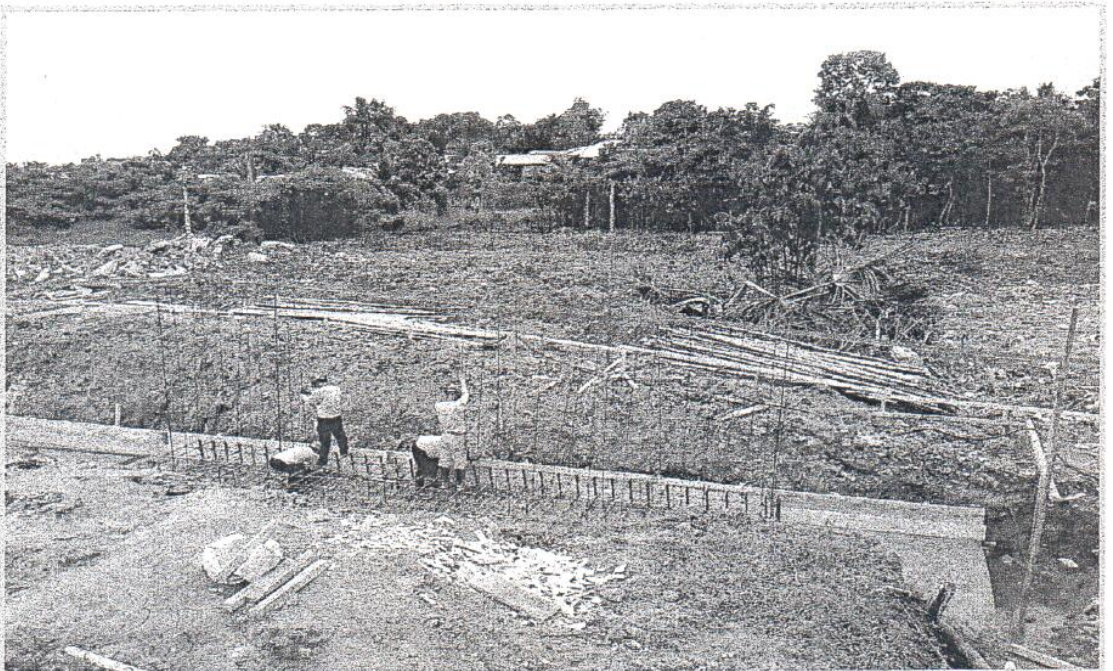
FOTO N°12: Colocación de Acero para Pantalla de Muro de Contención.
